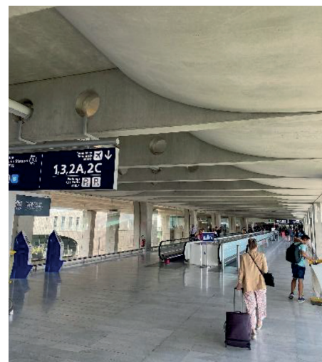
Figur 6: En korridor i CDG med bara hårda material. Den ger på grund av de välvda ytorna ett bekvämt dämpat intryck. Dessutom utan fläktbuller eller buller från åkbanden. Men behöver alltså inte fylla rummen med mineralullsabsorbenter för att få ett bra hörselintryck. Man hör inte heller resväskornas klappande över golvskarvar för här ligger golvplattorna tätt ihop utan fogar.
